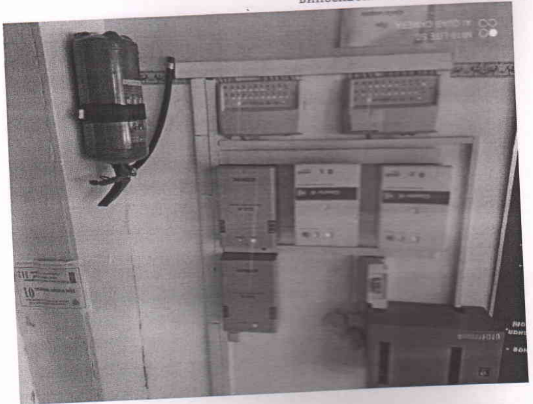
Фото 26. Пожарная сигнализация
